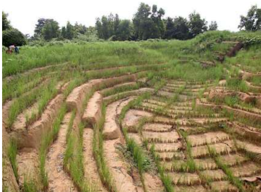
Figura 8.4 – Recuperação de ravinamento com capim vetiver no Congo. (Fonte: Elder Madruga).
