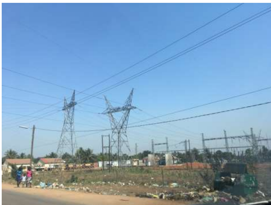
Fotografia 6.5 – Local de concentração de resíduos junto a uma subestação
