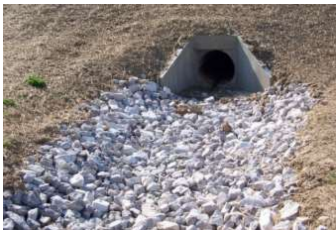
Figura 8.5 – Exemplo de bacia de dissipação em enrocamento.
